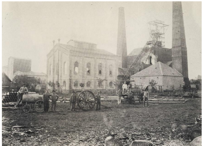
Bild 11: Anlage nach 1901 von einem Standpunkt aus der etwas mehr nach Links liegt. Foto aus J.Driessen
