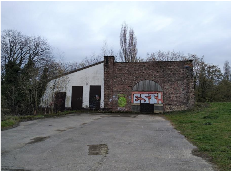
Bild 1: Die heutige Situation am Schachthaus im April 2023. Foto FW
